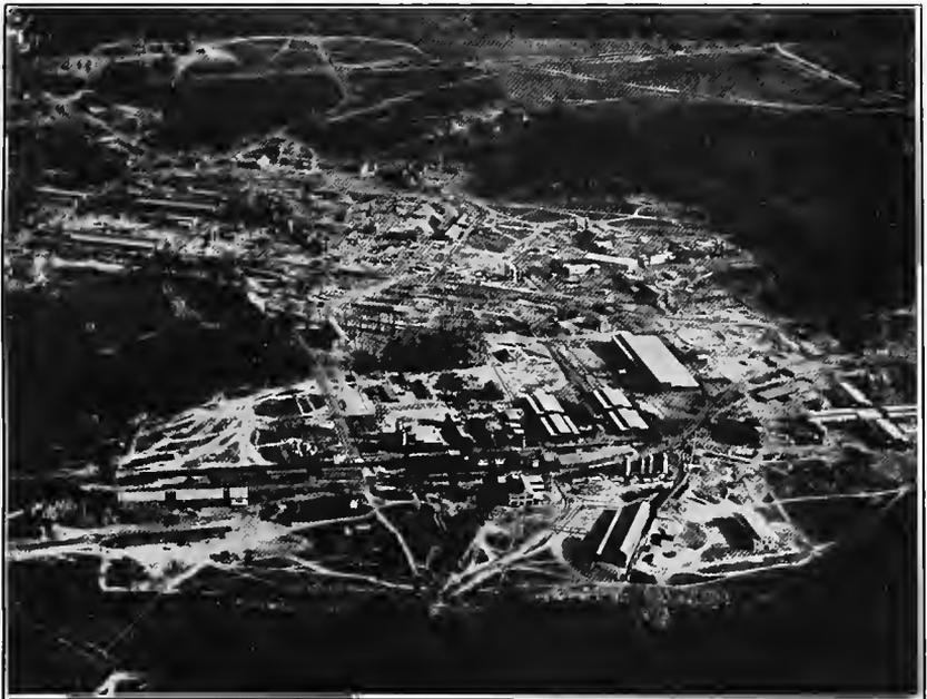
IN THE FOREGROUND THE CHLORINE PIPE LINE FROM CHLORINE PLANT PASSING TO CHEMICAL PLANTS IN RIGHT CENTER OF THE PICTURE. ON THE EXTREME RIGHT THE MUSTARD GAS PLANT. IN UPPER LEFT AND CENTER, VIEW OF FILLING PLANTS AND SHELL DUMPS.
