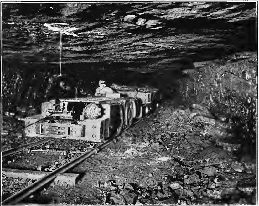
6-TON ELECTRIC LOCOMOTIVE PULLING A STRING OF COAL CARS.
